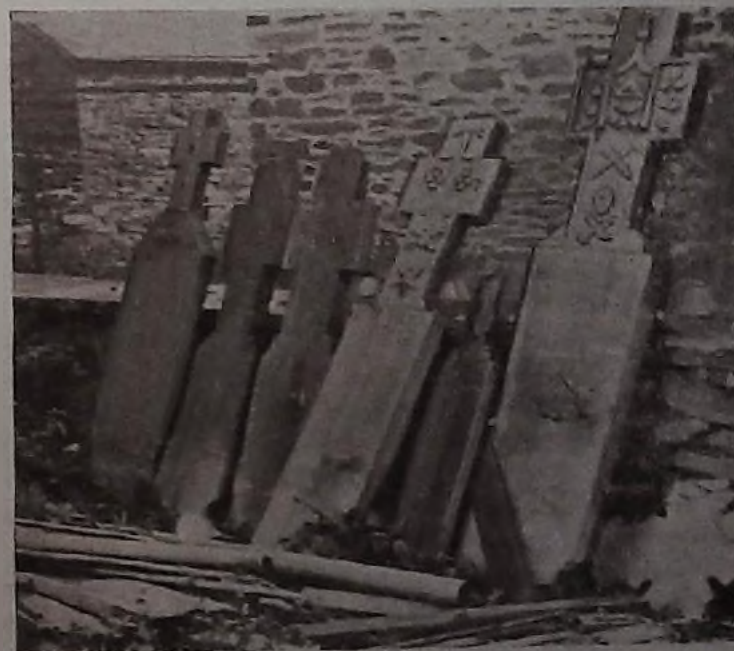
Au cimetière de Regné. Le danger auquel sont exposées les ardoises lors des travaux exécutés dans les cimetières.
