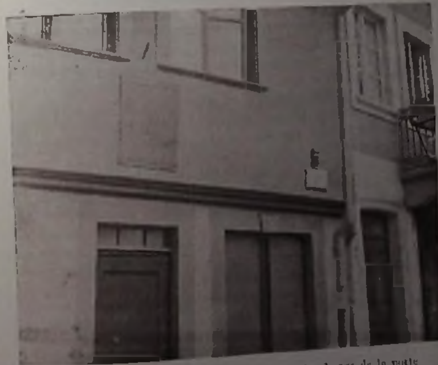
Rue du Renard prêchant à Strasbourg, n° 9. Au dessus de la porte d'entrée se trouve l'enseigne satirique. Au dessus de la 2 e porte l'ancre avec initiales : N. D. B. et le millésime 1760. A droite un obus provenant du bombardement le 25 août 1870.
