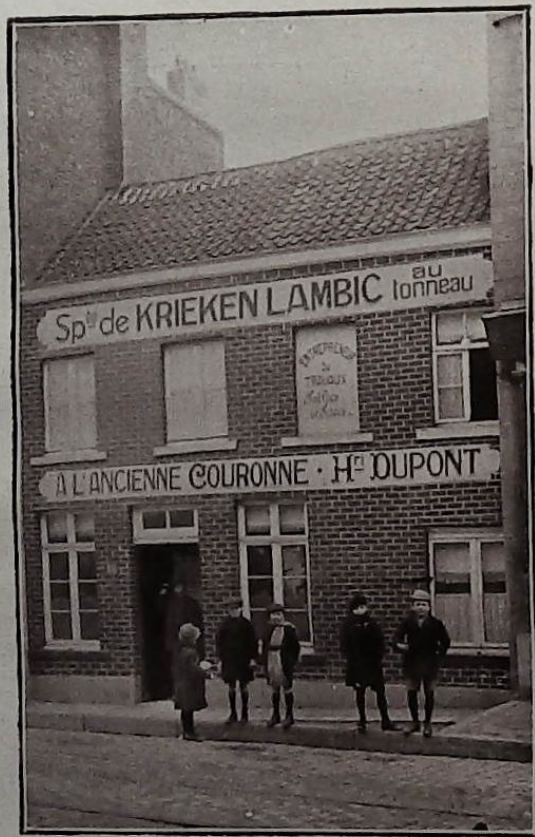
Cabaret « A l'Ancienne Couronne », chaussée de Neerstalle à Forest. (Photo de M. Charlier).
