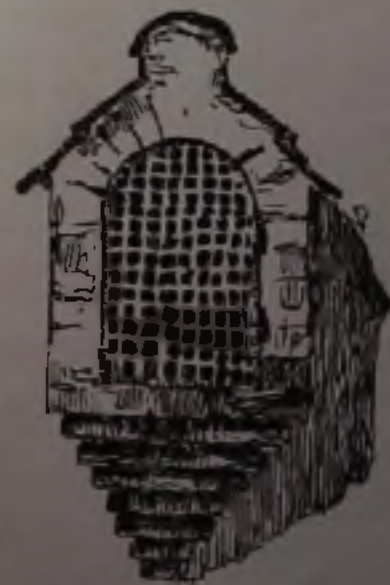
Céroux-Mousty. (Limoges). Chapelle dédiée à N.-D. de Lourdes, attachée au pignon d'une maison.
