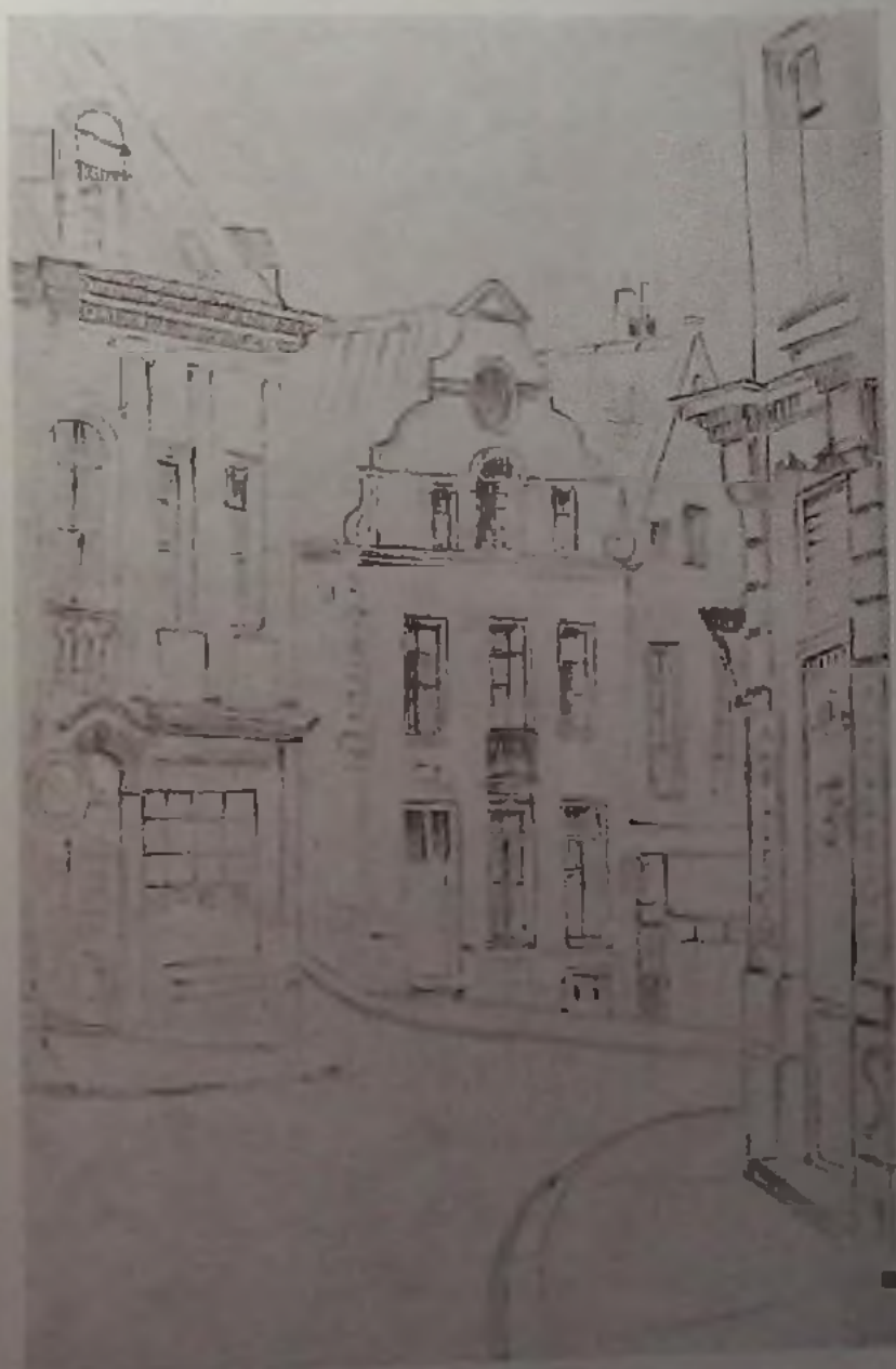
Vieille Halle-au-Blin Entrée de la Rue du Chêne et de la Rue de Villers.
