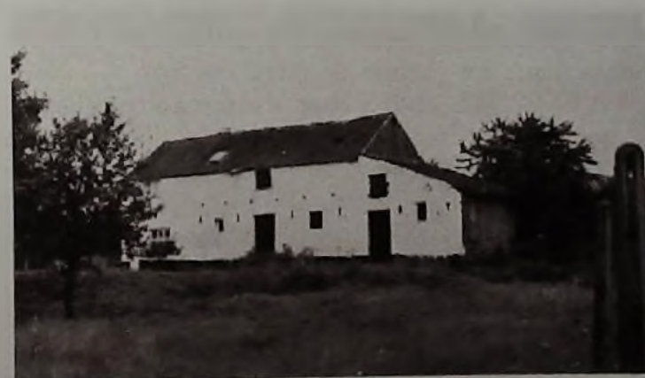
Fig. 1. — Ancienne ferme au lieu-dit Kattepoel (territoire de la commune de Schaerbeek). Voir texte.
