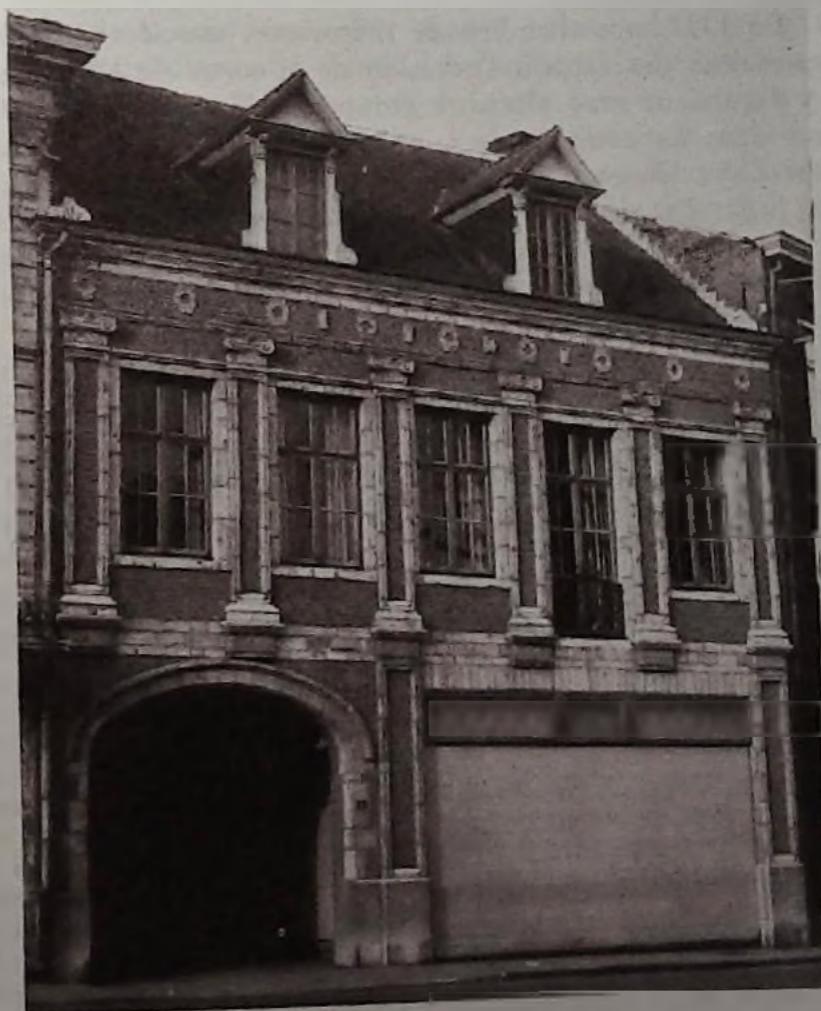
La maison n° 23, rue Neuve, portant le millésime 1707, de style néo-classique Louis XIV, anciennement l'auberge du « Cleynen Spieghel », où se réunissaient, dans la « chambre » au-dessus du porche, les membres de la « Fonteyn Caemer ». La façade fut restaurée en 1952, mais la partie à droite du porche sacrifiée à l'installation d'une vitrine moderne, brisant ainsi l'harmonie de cette très belle architecture. L'ensemble des deux fenêtres de chaque côté d'une porte était identique de proportions aux fenêtres et à la fenêtre-balcon de l'étage.
