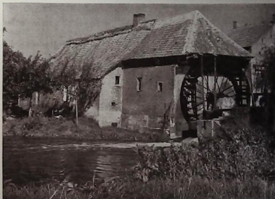
Moulin à vent à Tielon, sur l'Aa, et maison datant de la seconde moitié du xviii e siècle. Le moulin, encore en bon état et en activité, est classé ainsi que le paysage.
