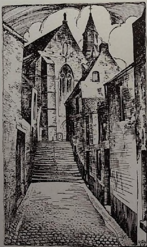
TIRLEMONT. — La rue des Escaliers.
