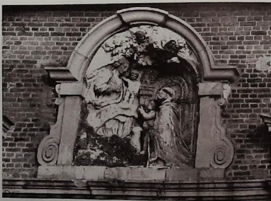
OPLINTER. — Détail du porche d'entrée de l'ancienne abbaye du Val des Vierges.
