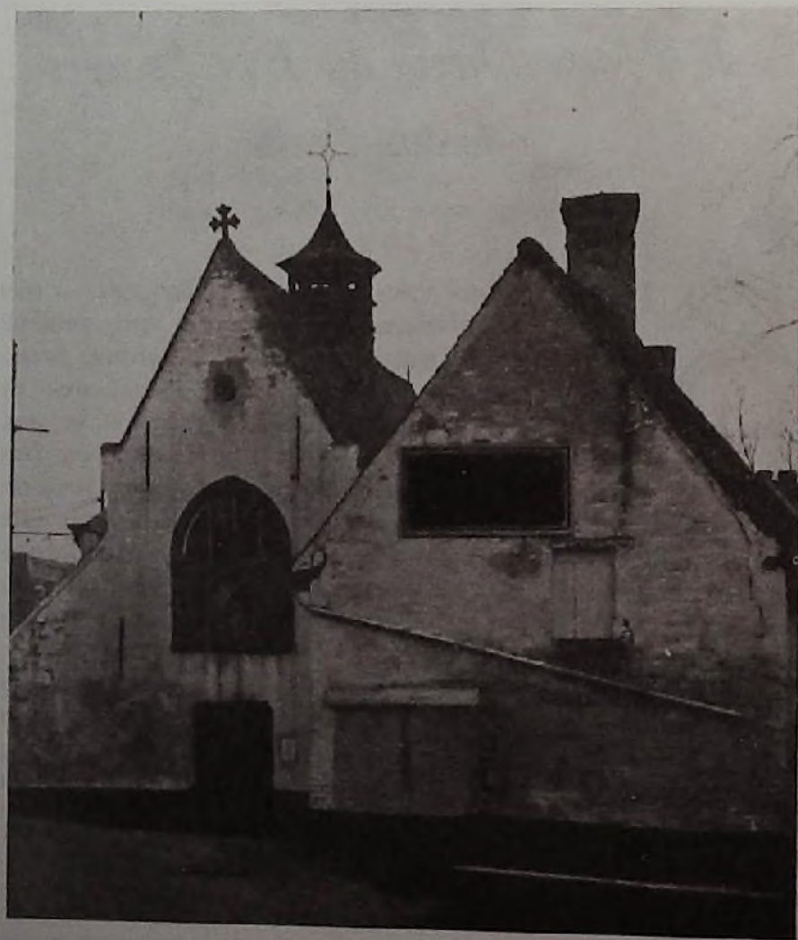
La chapelle de Notre-Dame du Bon Secours à Uccle-Stalle avant sa restauration.
