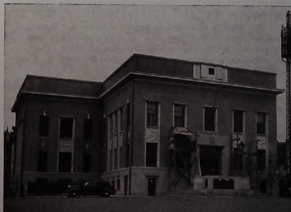
En 1939 la maison communale de Koekelberg a été agrandie. On a construit de nouveaux murs tout autour de l'ancienne construction.
