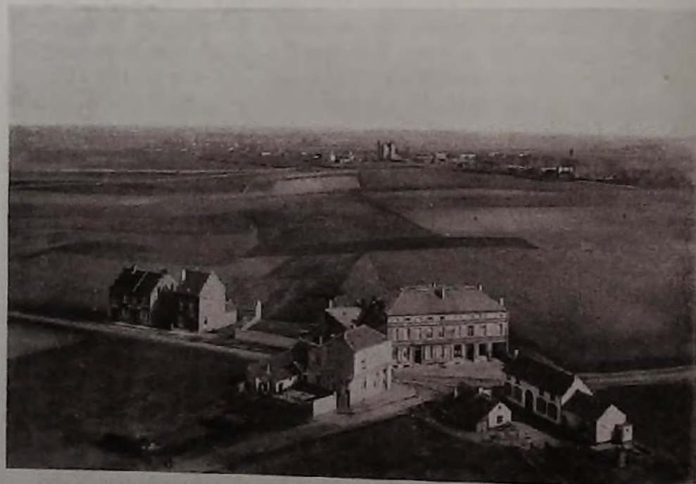
Vue prise du Lion avant la construction du Panorama.
