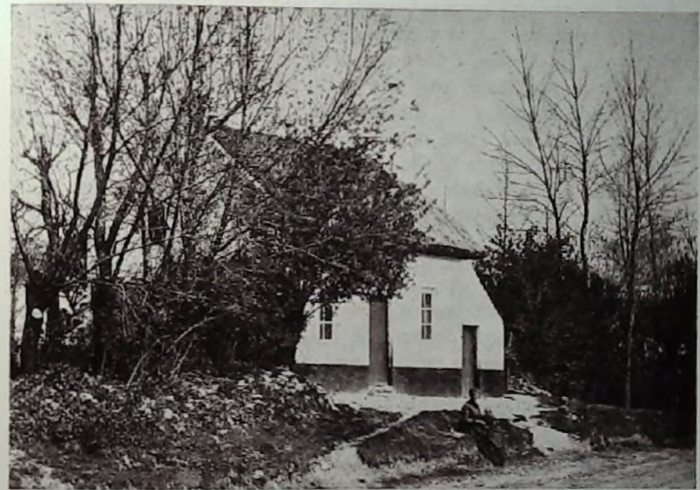
Maison s'élevant jadis en bordure du talus du Chemin Creux d'Ohain à l'emplacement du café Bovry 1912 et du « 1815 » en 1961.
