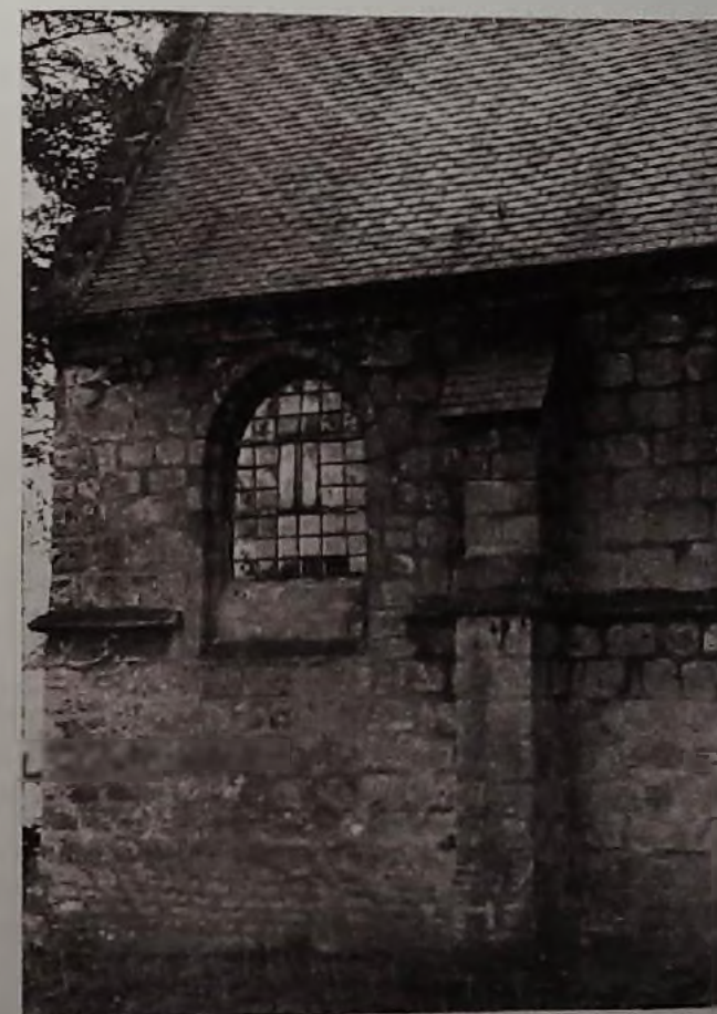
Chœur : façade latérale Nord.
