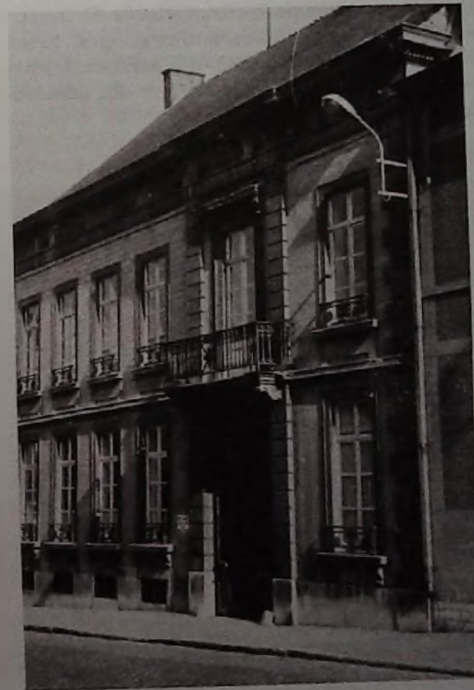
Maison d'Auguste DEFOER à Jodoigne
