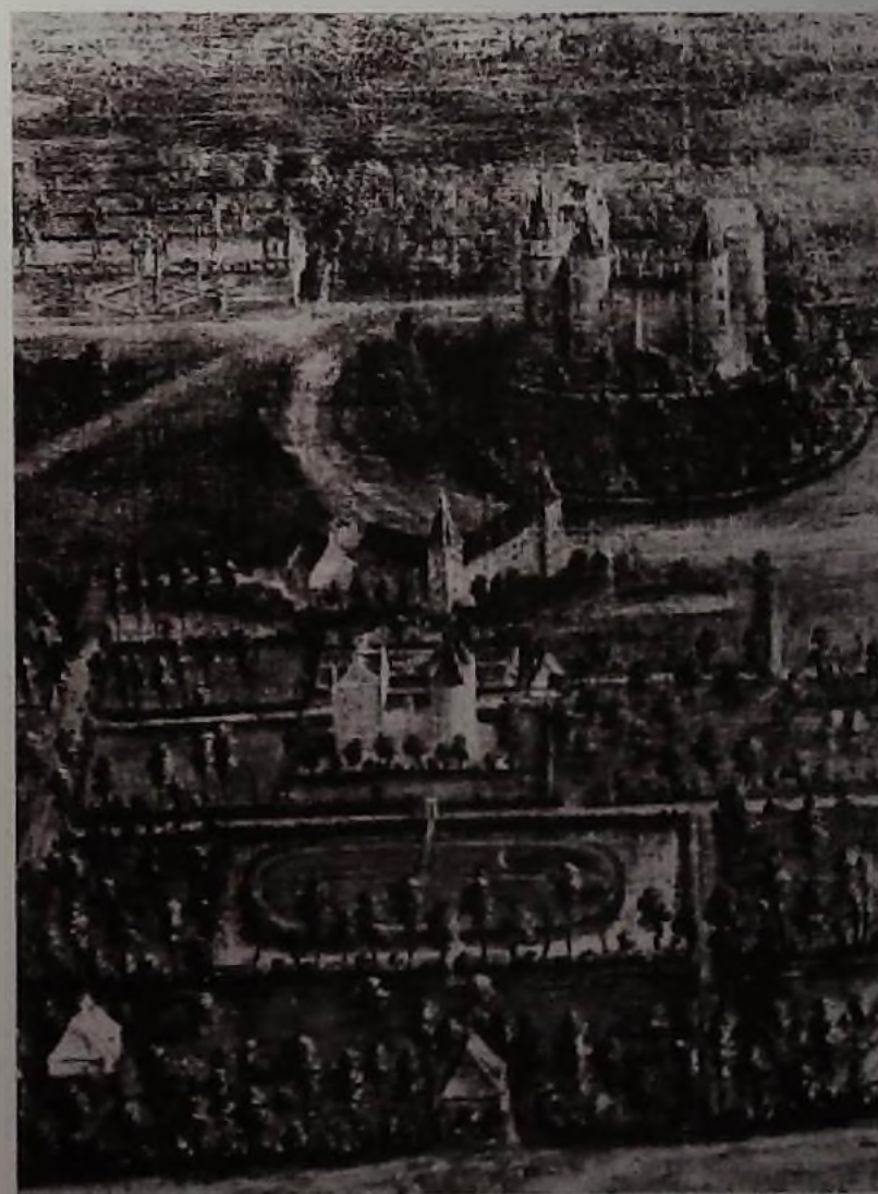
Immenraet - Panorama de Gaasbeek - détail (M. Duerinckx, Rutsbroek)
