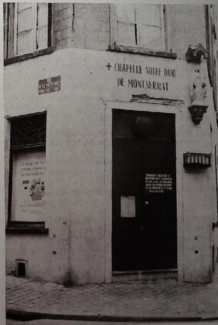
Au coin de la rue de la Prévoyance et de la rue Montserrat, au cœur des Marolles à Bruxelles a été installée une chapelle Notre-Dame de Montserrat, à l'emplacement exact de la chapelle du 17e siècle, appartenant aux religieuses Apostolines Marcolles.
