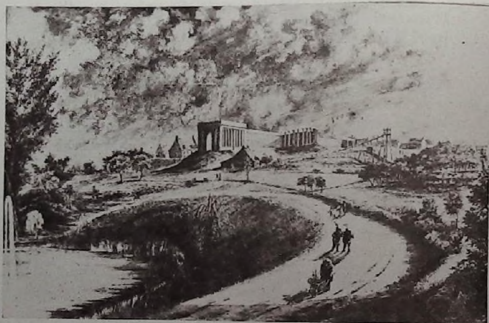
Construction des bâtiments du Jardin Botanique à Bruxelles.
