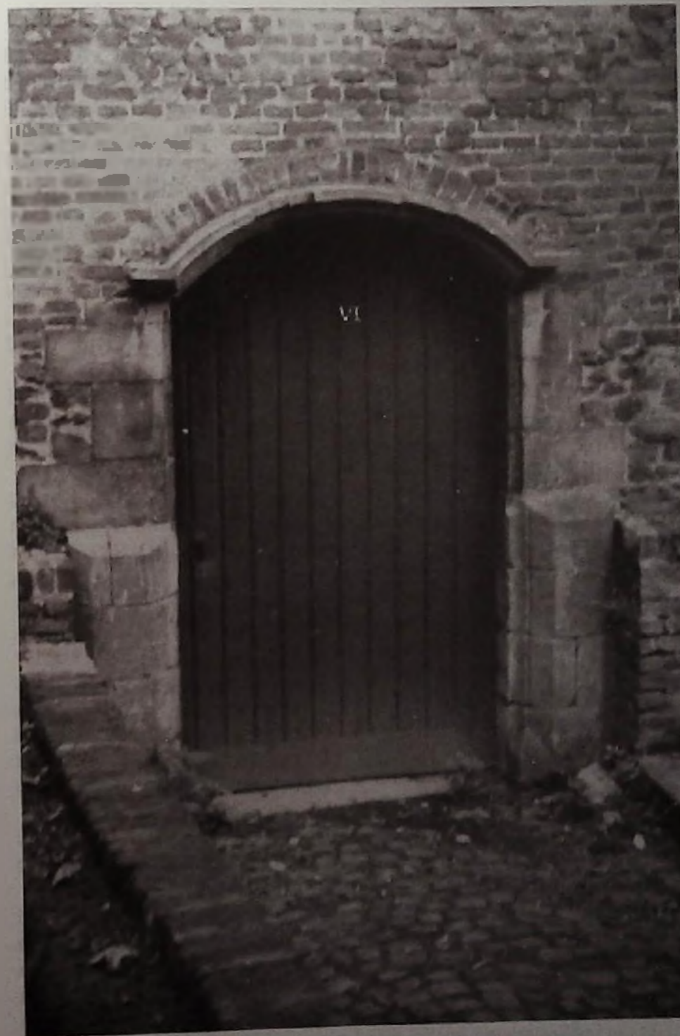
Porte donnant accès au parc du château
