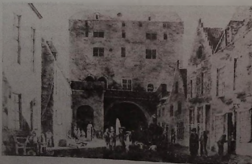
La même porte, vue de l'intérieur de la ville. La Fontaine de la Samaritaine se trouve à gauche entre la guérite et l'angle de la maison. Ses vestiges figurent actuellement dans le cloître lapidaire du Musée Royal Art & Histoire, Avenue des Nerviens. (Cinquantenaire).
