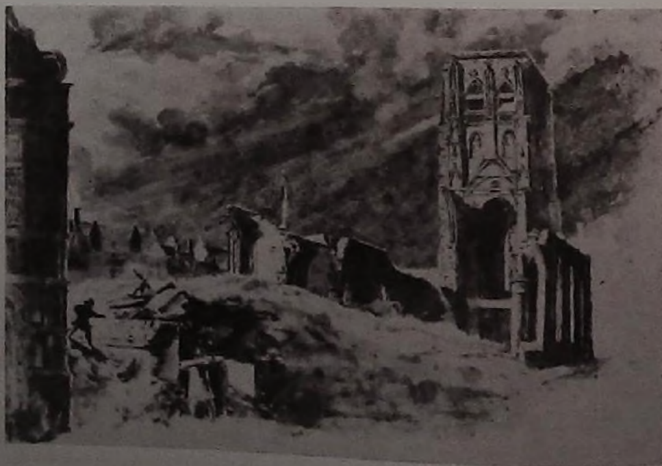
Eglise Saint-Gery, en démolition.
