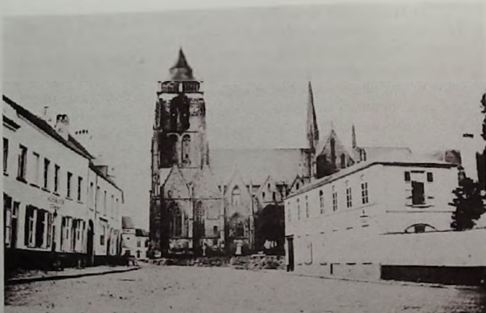
« Hel Pleintje » Place publique vers 1880. Les travaux de déblayement autour de l'église ont débutés. A droite le pensionnat Jamar.
