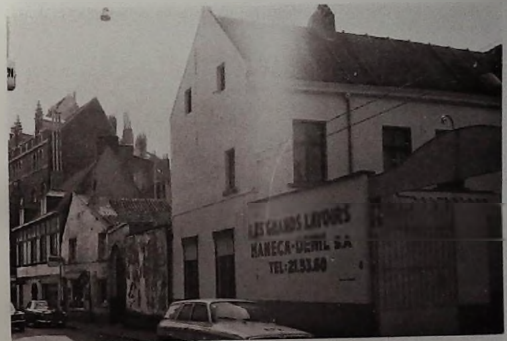
Ancienne ferme du chapitre (XV e -XVI e siècle) dans la rue Saint-Guidon convertie en petit atelier et lavoir.
