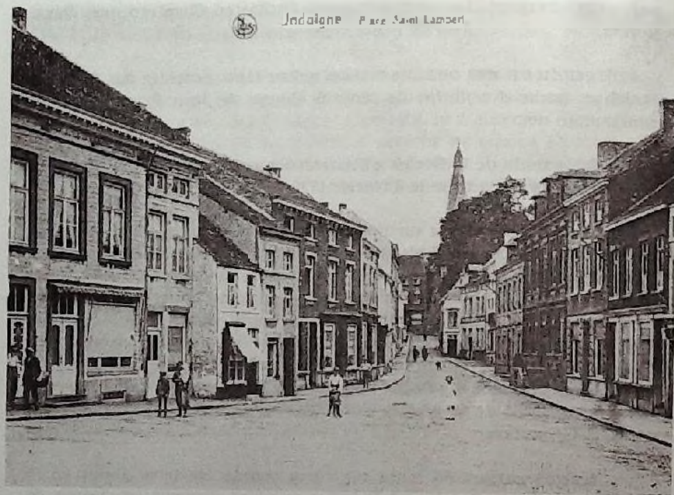
JODOIGNE. Le nouveau presbytère précédé d'un perron fut acquis pour la somme de 8.860 francs, vers 1845.
