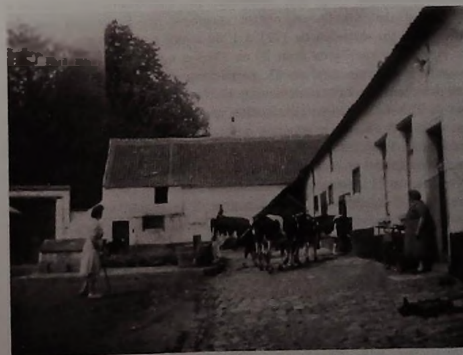
Ancienne ferme abbatiale, Cour du Kraalenhof — 1941.
