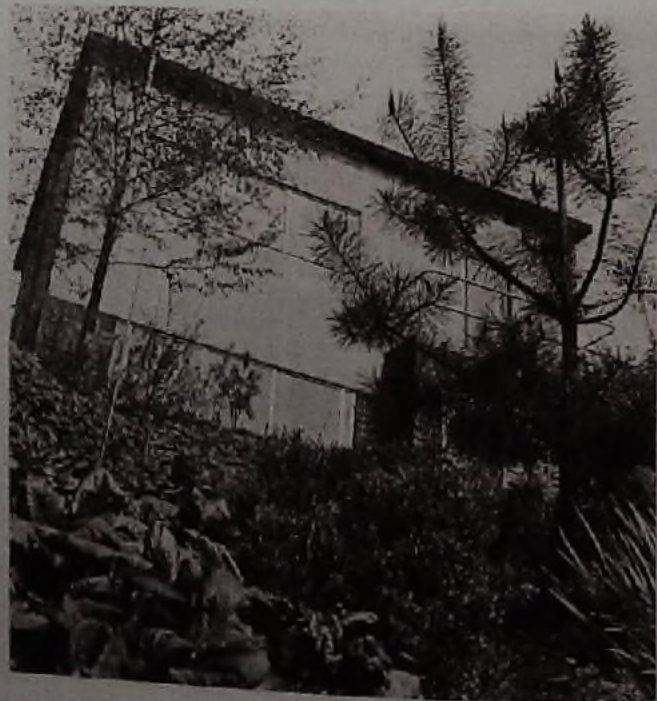
L.H. de Koninck — Habitation personnelle de l'architecte, avenue Fond'Roy à Uccle, 1924. (Document Archives d'Architecture Moderne)
