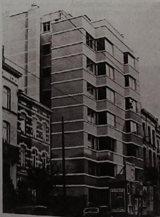
J.J. Eggerlix — Immeuble d'appartements et salle de spectacles, avenue de l'Hippodrome à Ixelles, en collaboration avec l'ingénieur R. Verwiltghen, 1935. (Photo J.C. Faiderbe)
