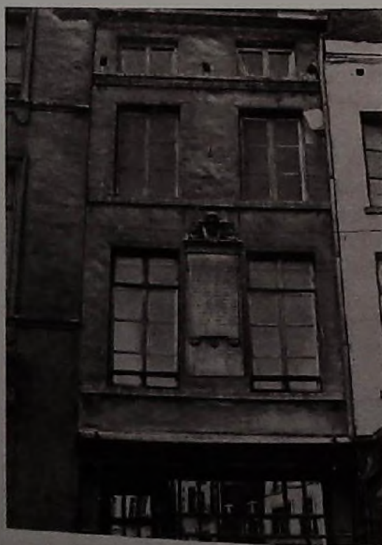
La façade de la maison où demeurait Anneessens, rue de l'Hôpital 17, à Bruxelles
