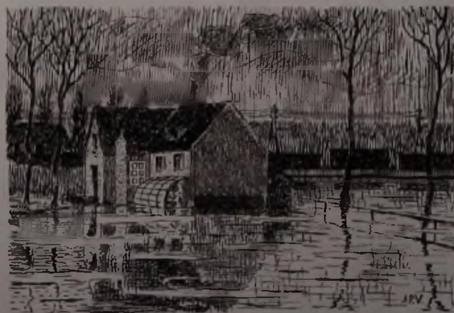
Inondations à Forest (1930) maisonnette dite « 't Scheurre kastielje »
