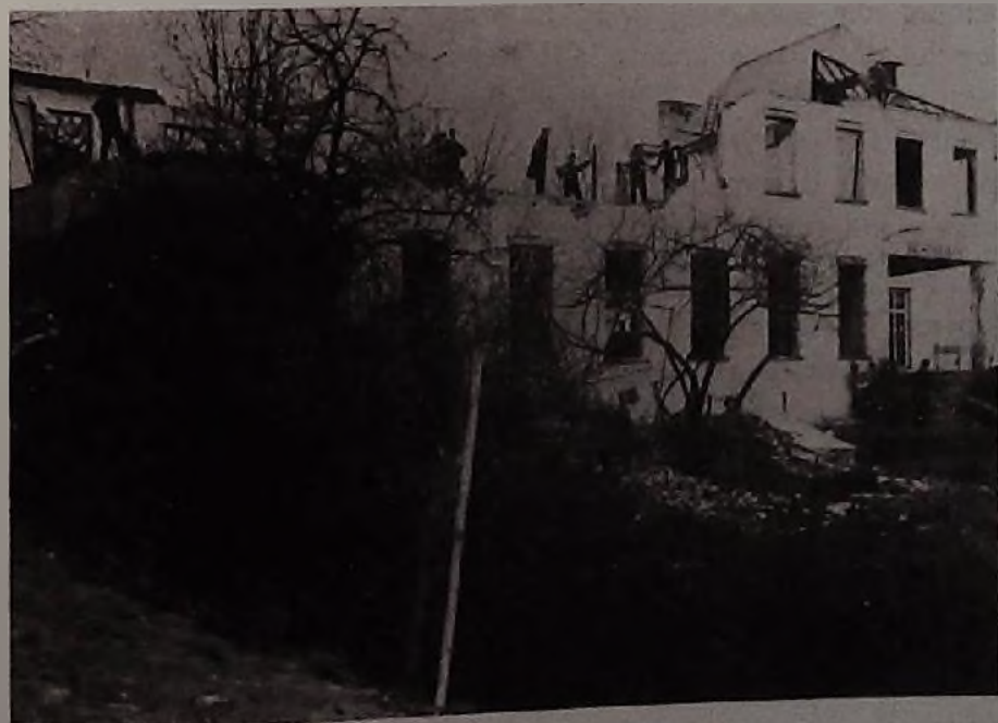
L'ancienne annexe de la Maison Haute en démolition. Vue prise en 1900. (Coll. Mlle Smets; photo J. Delmoulié).
