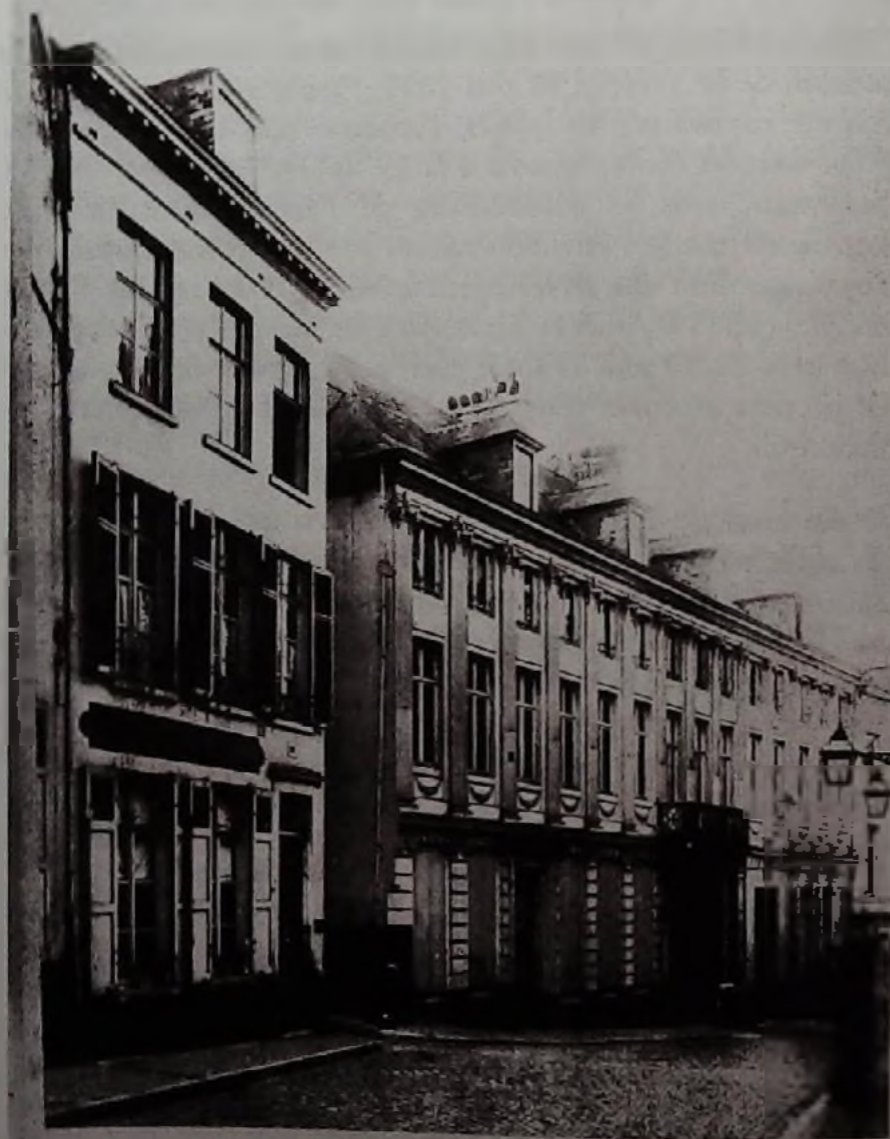
MAISONS A DEMOLIR RUE DU CHÊNE, POUR LA CONSTRUCTION DU NOUVEL ATHÉNÉE.
