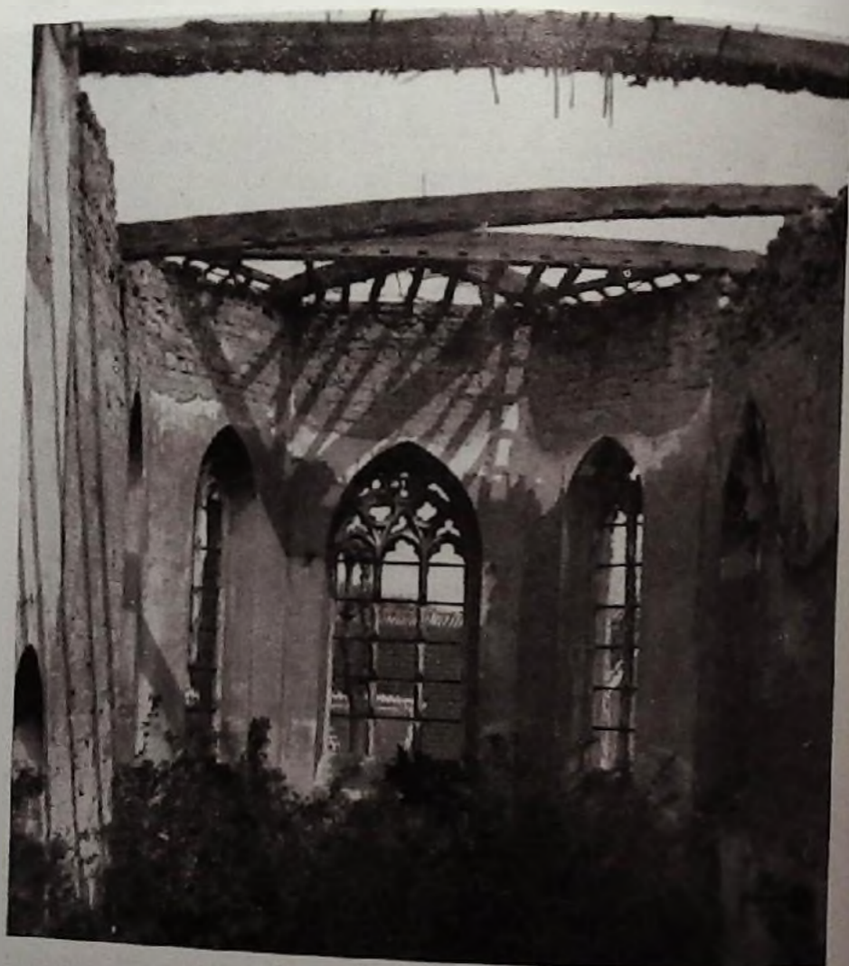
Lincent. — La vieille église Intérieur. — Vue générale sur le chœur. (Copyright A.C.L. Bruxelles)
