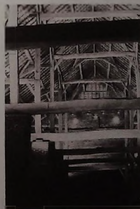
3 Ferme de Profondval Grange. Net centrale et charpente (vue vers le sud).
