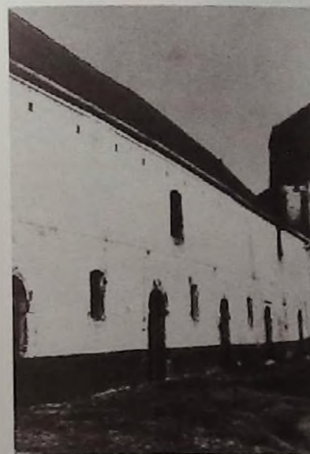
1 Ferme de Profondval. Vue des écuries avant leur aménagement en logement
