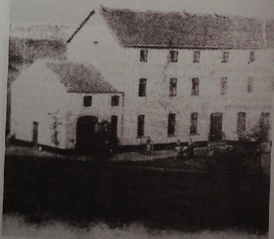
Vue de la ville des Trois-Portails en 1884.
