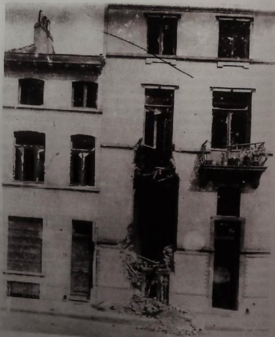
Démolissement du jeudi 25 mai 1944 à 9h10, trouée d'une bombe qui n'a pas explosé. (n° 77, rue St Denis) (Photo: Cercle d'Histoire de Forest)
