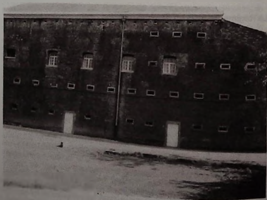
Prison de Vilvorde - vue de l'extérieur (Photo Paul LOX)
