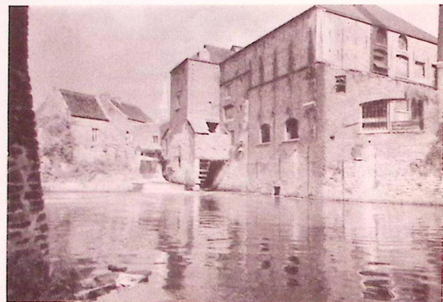
Le vieux moulin à eau est toujours actif.
