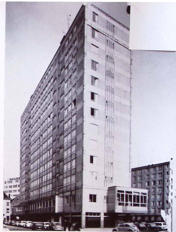
Bruxelles : logements de type urbain, rues des Potiers et du Vautour.
