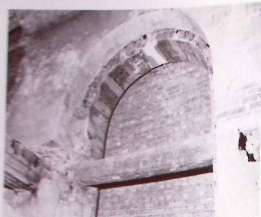
Dernière cette porte obturée, des kilomètres de souterrains.
