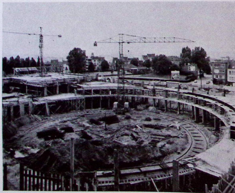
Différents aspects de Forest-National en construction.
