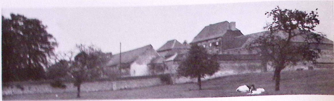
Vue d'ensemble du château-ferme de Vaillantpont.
