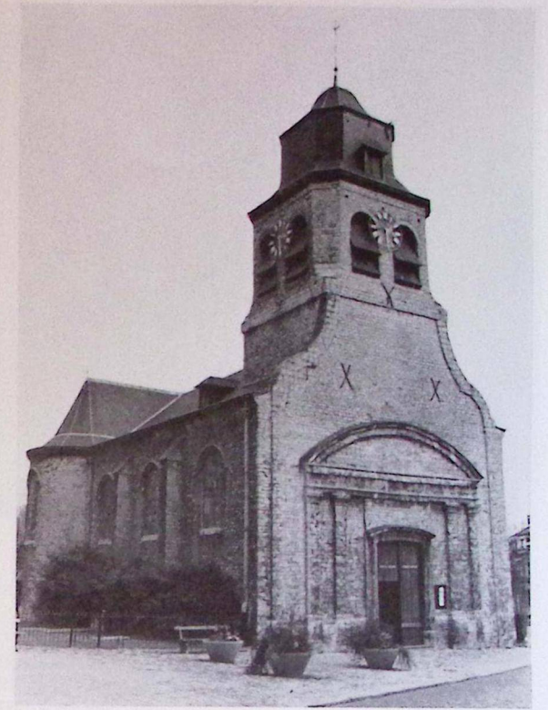
L'ancienne église Saint-Nicolas, à Neder-over-Heembeek, construite en grès lédién, à la fin du XVII e et au début du XVIII e siècle, fut désaffectée en 1932. Elle fut transformée en musée du folklore avant d'abriter le Centre Culturel de Bruxelles.
