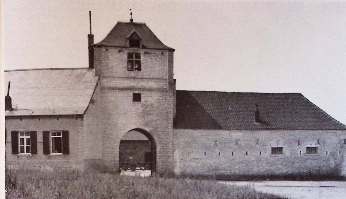
Avec Jodoigne, c'est à Mélin que l'on trouve le plus grand nombre de constructions élevées en pierres de Gobertange, telle la Ferme de la Hesperée (notre document) avec son porche fortifié (XVe siècle).
