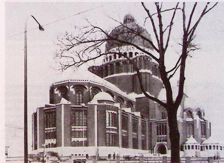
Dominant le plateau de Koekelberg, la Basilique Nationale du Sacré-Cœur est, par ses dimensions, la quatrième église du monde. Elle a été construite, en grande partie, sous la direction de l'ingénieur-architecte Paul Rome, d'après les plans dressés par l'architecte gantois, Albert Van Huffel. Le style du sanctuaire, d'inspiration moderne, présente toutefois d'indéniables réminiscences de l'art byzantin.
