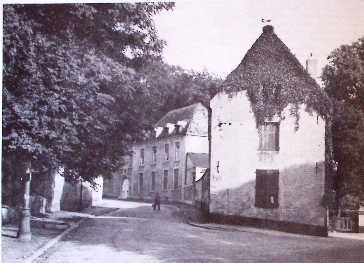
Rue Victor Gambier à Uccle : dans le fond l'habitation où vécut Raspail jusqu'en 1862, année où il décida de rentrer en France.
