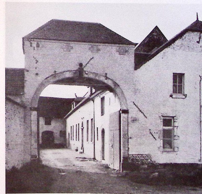
Ferme Staquet ; porche et habitation du fermier.
