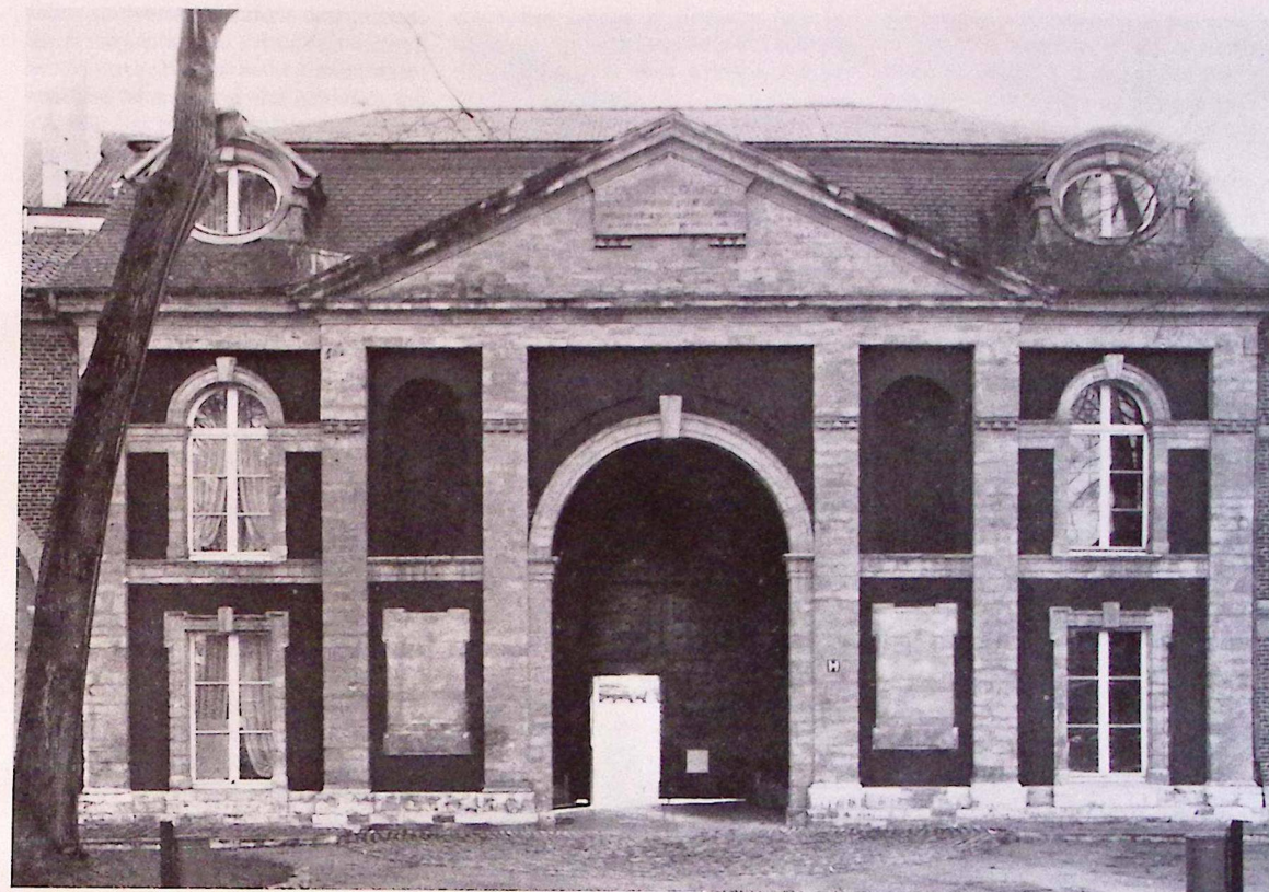
Le même portail vu de l'intérieur du domaine.
