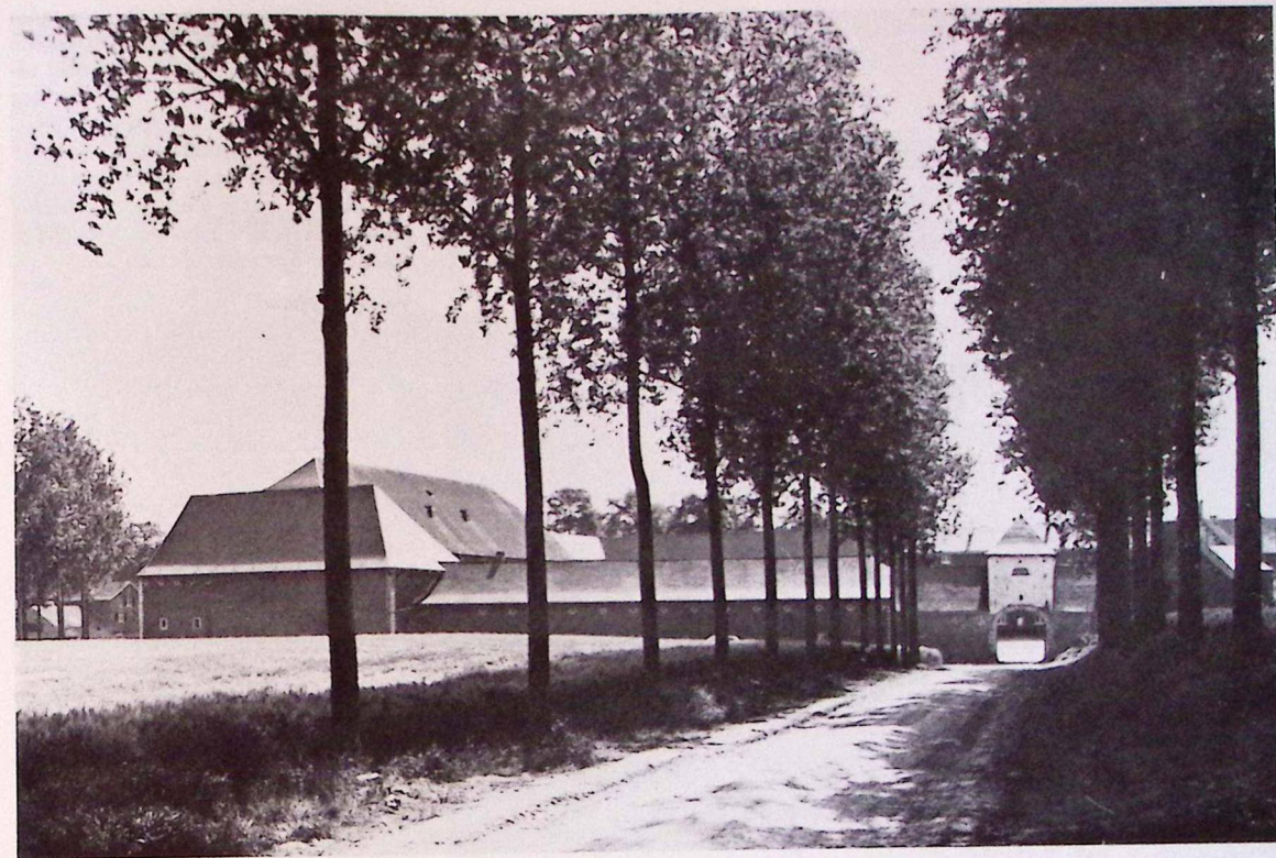
Ci-dessus : aux confins de Bossut-Gottechain : la ferme de Beusart qui règne, aujourd'hui, sur des terres ayant appartenu à l'abbaye d'Aulne, est l'une des plus remarquables de tout le Brabant wallon.
