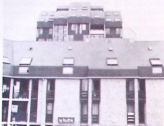
Ci-dessus : un des multiples aspects de Louvain-la-Neuve, tel qu'on le découvre d'une des terrasses de la place des Wallons.
