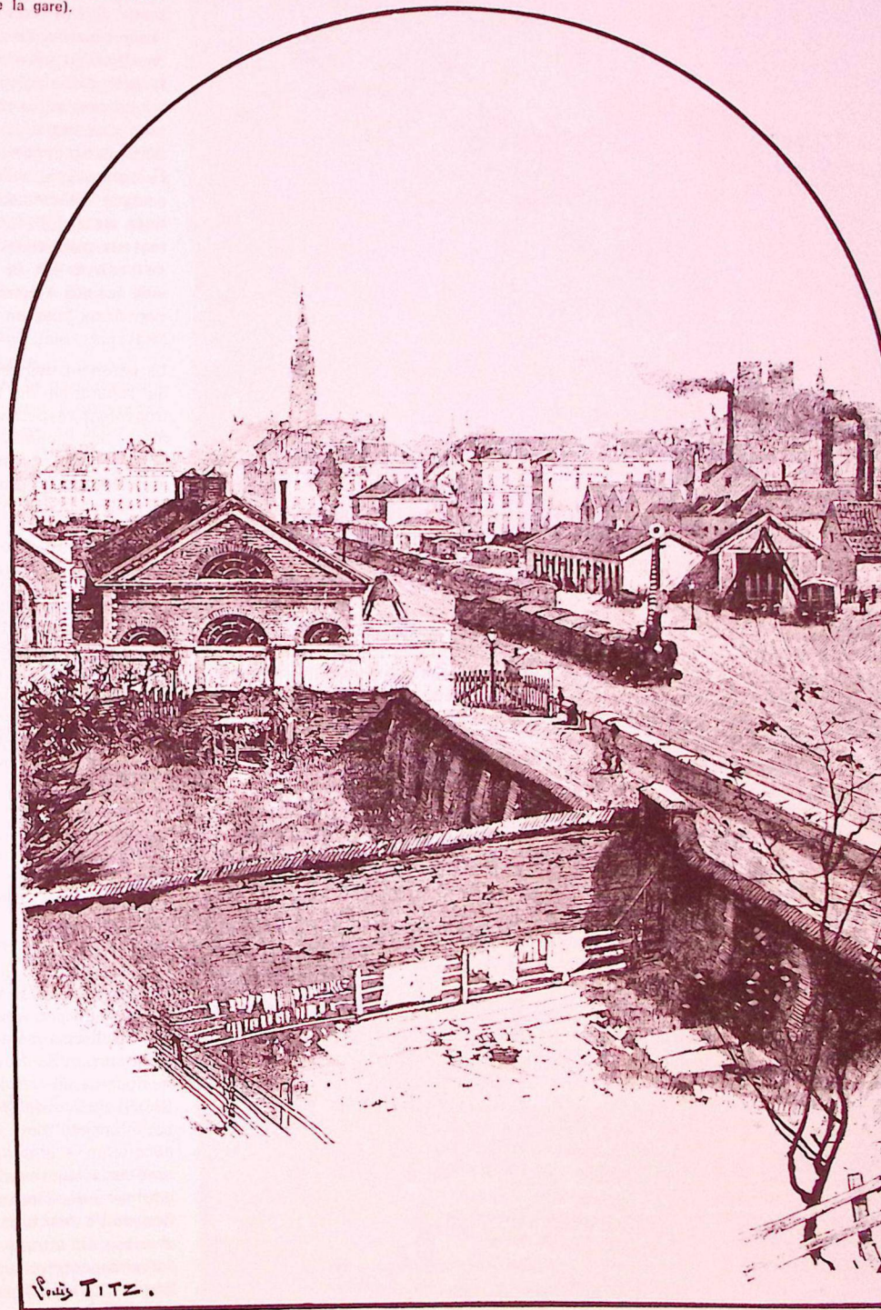
La gare des Bogards (dessin de Louis Titz d'après une photographie prise immédiatement avant le déplacement de la gare).
