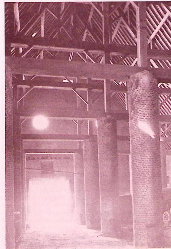
Intérieur de la grange de La Ramée. Vingt-quatre colonnes en briques soutiennent une forêt de poutres de chêne. On y éprouve l'impression d'être tout petit, presque écrasé dans cette « cathédrale de la terre ».
