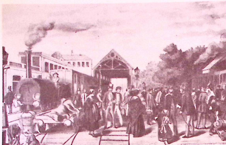
La gare de Bruxelles-Allée Verte en 1835.
