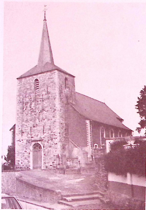
Ci-dessus : l'église Saint-Pierre, à Folx-les-Caves, fut reconstruite en 1777-1780, à l'exception de la tour d'origine romane.
