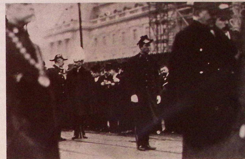
Ci-dessus : funérailles de Léopold II (22 décembre 1909). A l'arrière-plan, le palais en cours de rénovation et les derniers échafaudages. En bas : le Palais Royal en 1979. (lavis de l'auteur).
