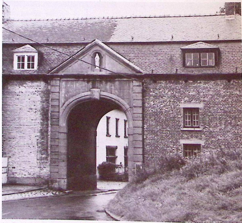
La Porte Sainte-Lutgarde ou d'En-Haut (vue prise de l'extérieur de l'enclos) date de 1770.
