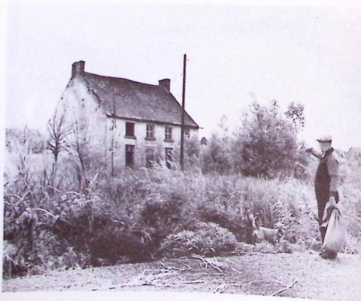
Cuesmes : la Maison Van Gogh avant sa restauration.
