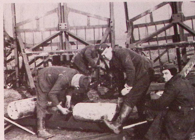
L'équipe du Génie monte les galets de roulement sur les grilles Cointet.
