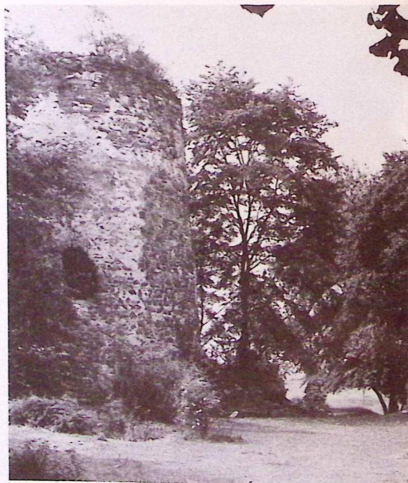
Walhain-Saint-Paul: un aspect des ruines du château fort.
