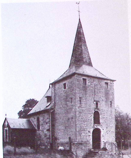
Autre-Eglise : la ravissante chapelle Saint-Feuillien, au hameau d'Hédenge.
