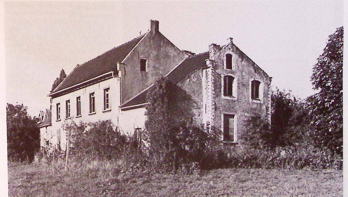
Kortenberg : le presbytère présentement à l'abandon sera probablement restauré par les soins de l'Administration communale.
