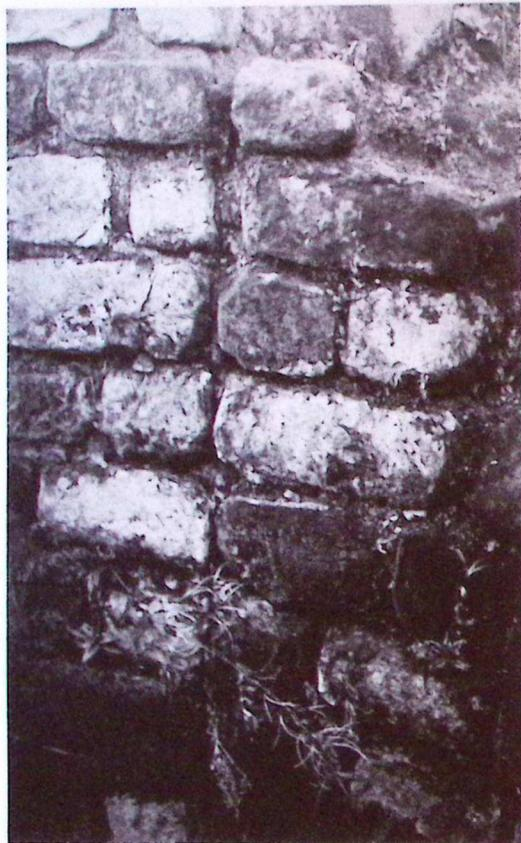
Détail du parement intérieur du couloir d'accès à la cave montrant une reprise dans la maçonnerie (janvier 1981).
