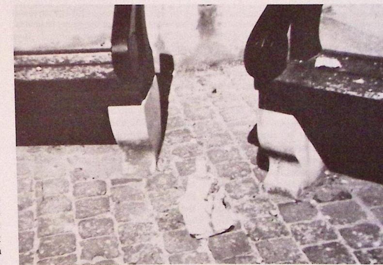
Des pierres sculptées des balustrades et pinacles de la façade latérale sud se sont détachées. Certaines sont retenues par les corniches, d'autres menacent la sécurité des passants. On distingue nettement l'effet de la corrosion sur les pierres de la balustrade sud.
