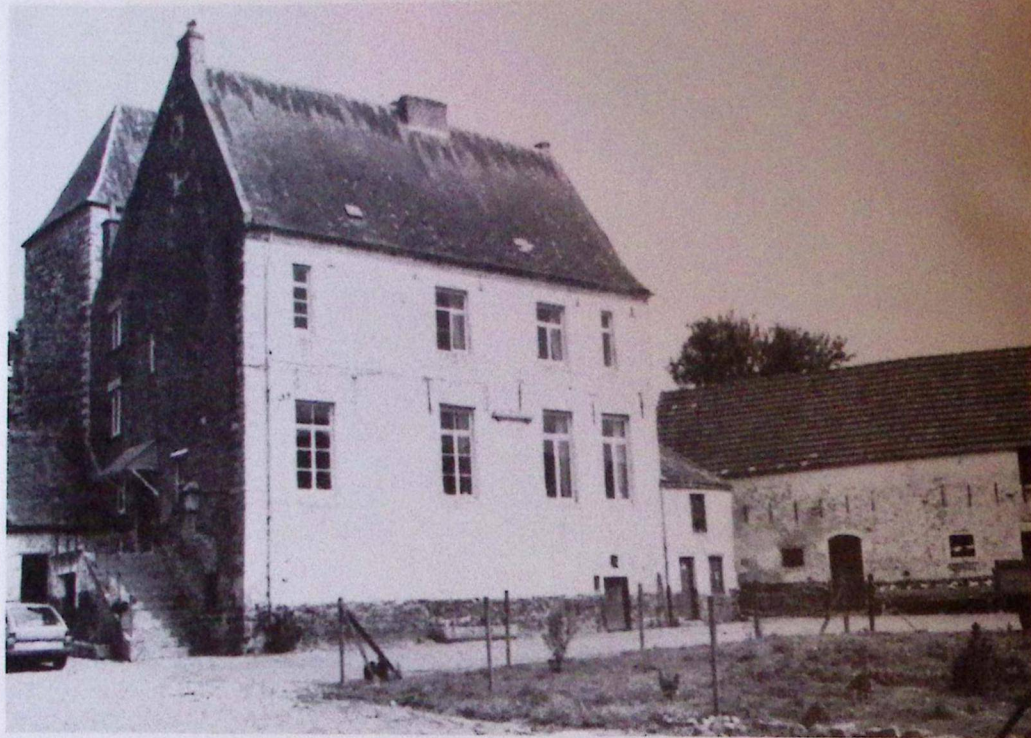
Offus : la Grande Cense, en forme de quadrilatère, est dominée par un beau corps de logis à deux niveaux derrière lequel se dresse une tour en épais moellons de grès.
