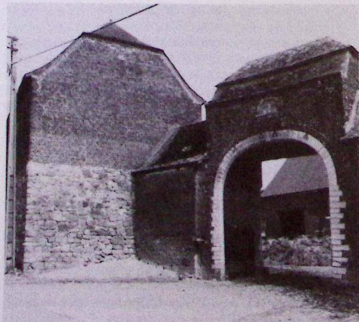
Offus : la Cense Seny forme un bel ensemble de constructions rurales (XVIII e siècle) en briques et moellons, auxquelles on accède par un porche en arc surbaissé.
