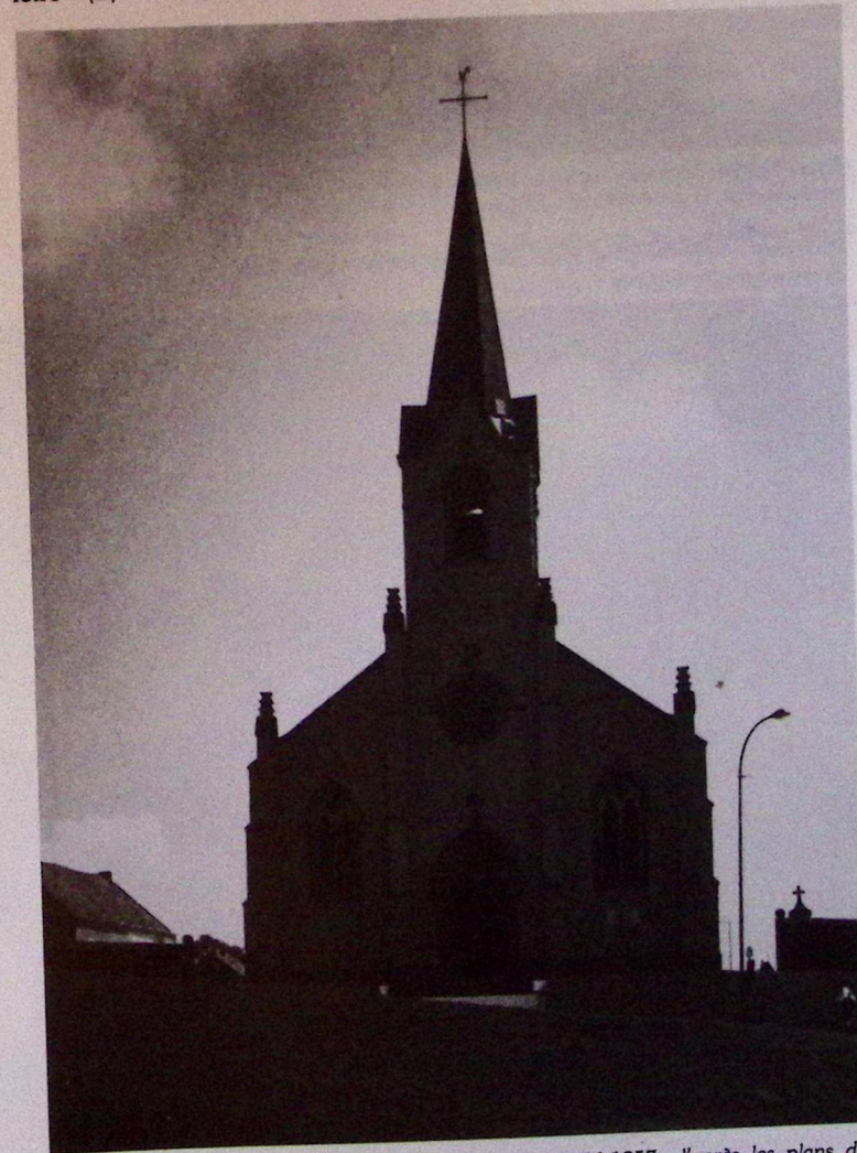
Plancenot : l'église Sainte-Catherine fut édifiée en 1856-1857, d'après les plans de l'architecte provincial Emile Coulon.
