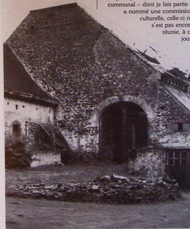
La grange (1609-1621) forme l'angle nord-ouest de la ferme.
