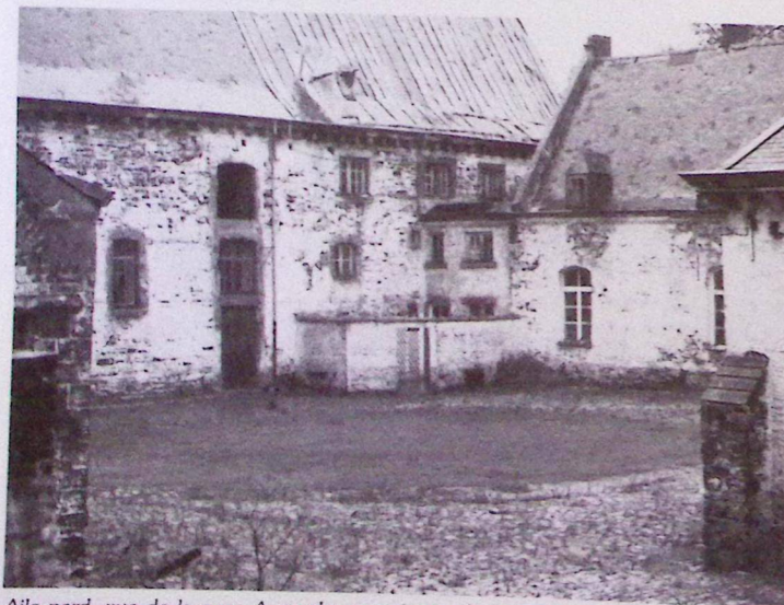
Aile nord, vue de la cour. A gauche, une écurie. A droite, le maître-logis dominant les autres bâtiments.
