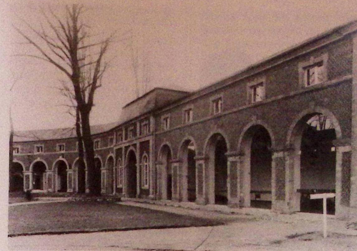
Une des ailes de l'ancienne abbaye de Forest, qui servait jadis de remise.
