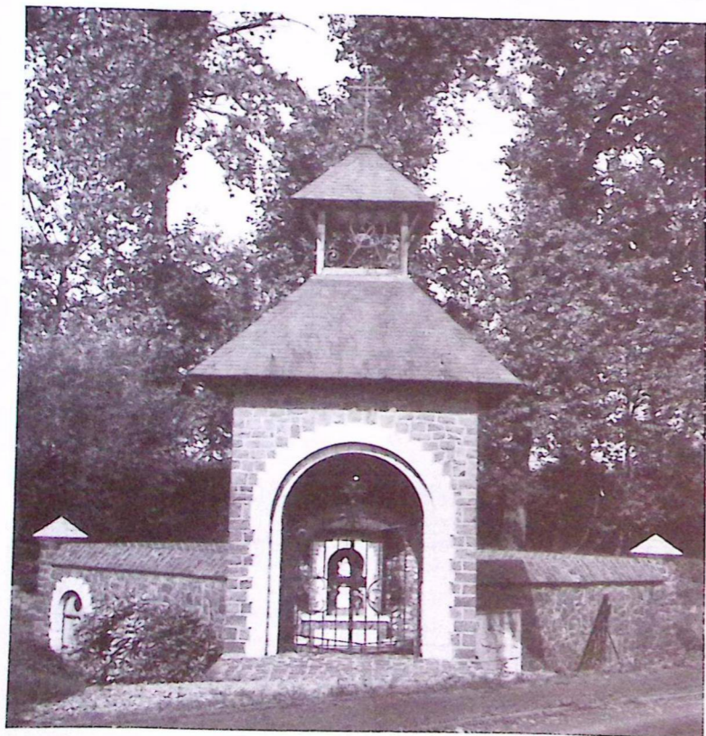
Incourt : la chapelle actuelle, dédiée à sainte Ragenufle, date de 1953.
